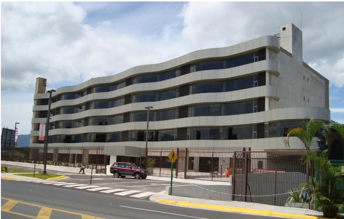
Edificio MIRA, dedicado al comercio y servicios en el Distrito Zapote.
