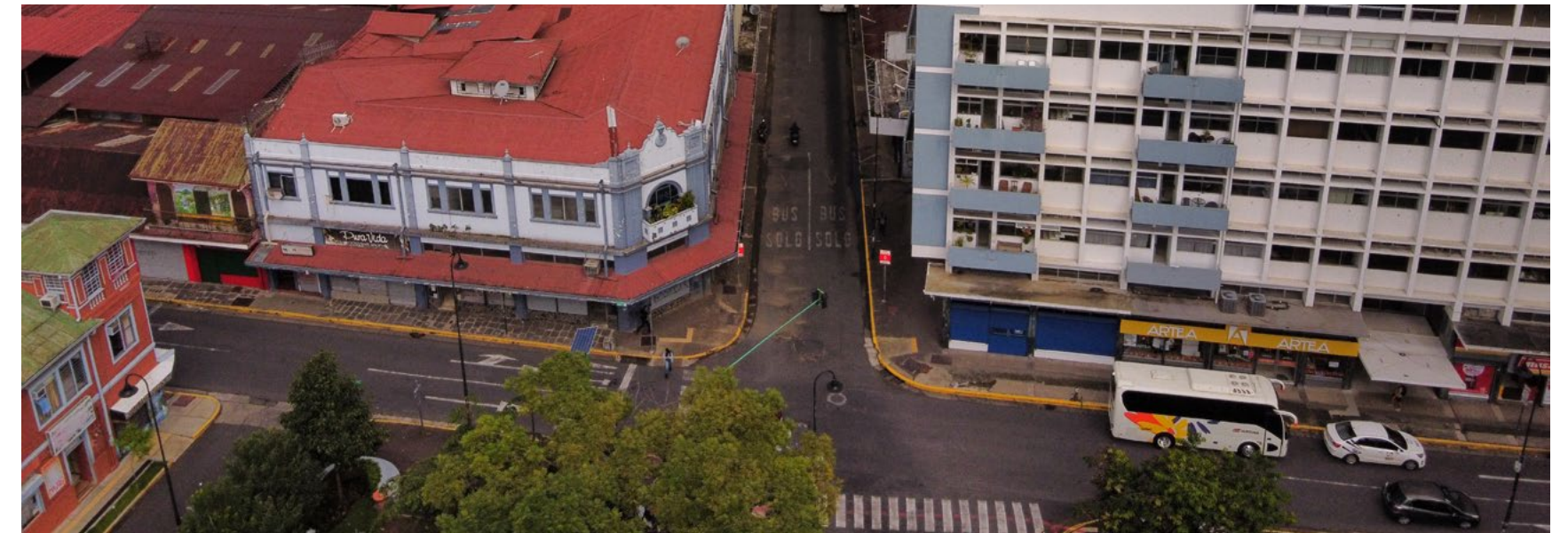
13 Imagen 7: Vista aerea del comienzo de la Av. 3, desde el Parque Morazán. San José, Costa Rica. Superwien (2025).
